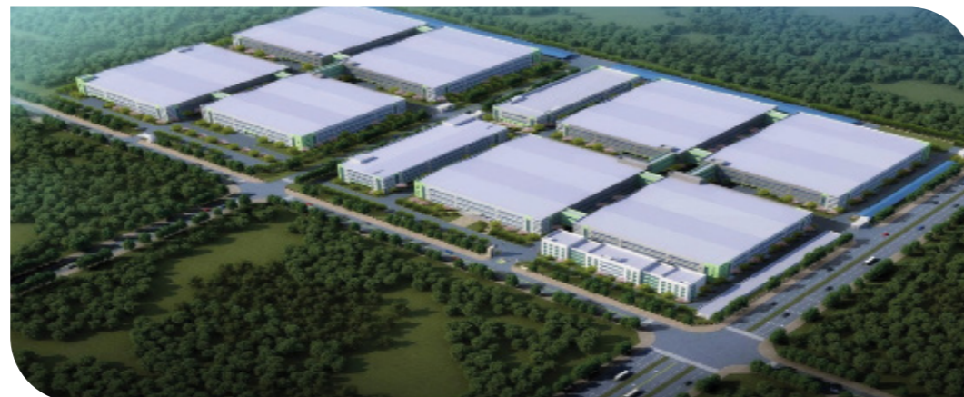
NHÀ MÁY GOERTEK BẮC NINH
