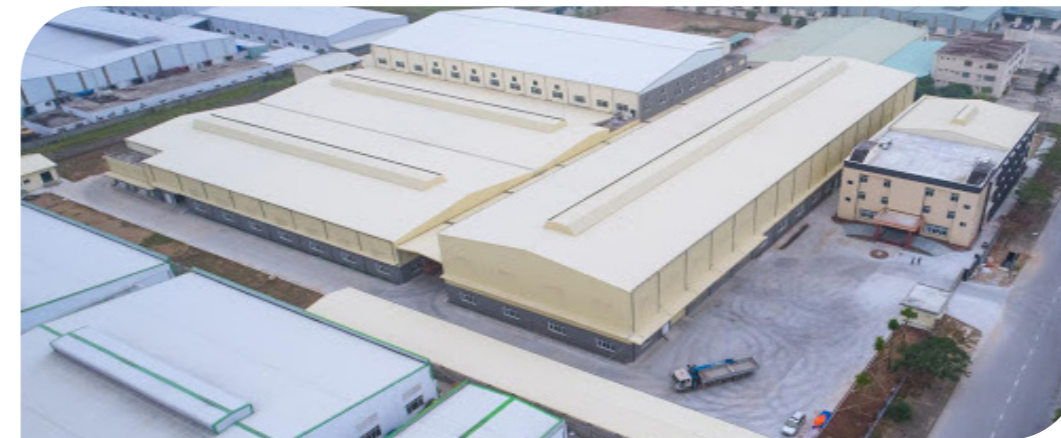
NHÀ MÁY NGŨ KIM TAILIAN
