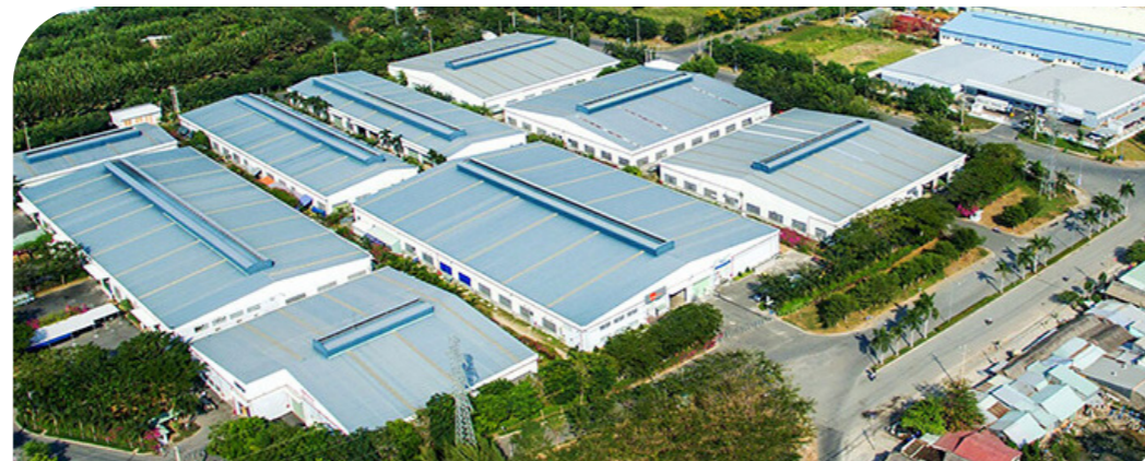
KHU CÔNG NGHIỆP VÀ ĐÔ THỊ NAM SƠN - HẠP LĨNH, TP BẮC NINH
